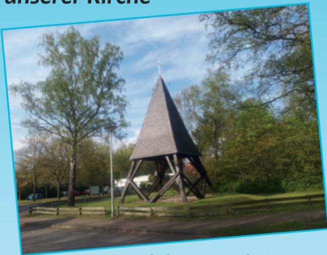
Die untere Holzkonstruktion des Glockenturms ist dauerhaft ungeschützt der Witterung ausgesetzt. Insbesondere an den Verbindungsstellen der einzelnen Holzbauteile dringt Feuchtigkeit ein und schädigt das Holz. Die Konstruktion erfordert ständige Instandsetzungsmaßnahmen.
